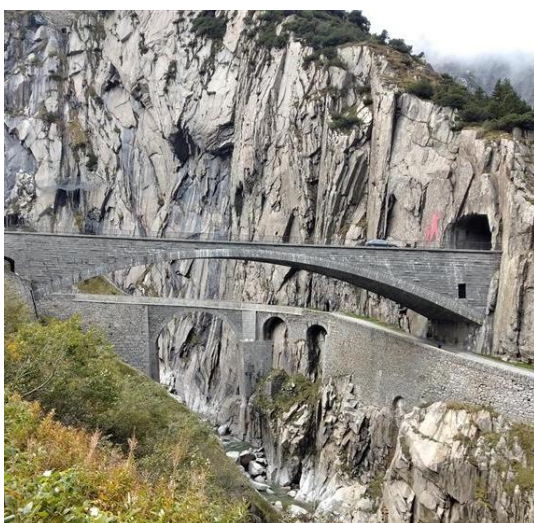
Die zweite und dritte Teufelsbrücke. Von der ersten, 1799 zerstörten Brücke, sieht man nur noch das Fundament des Pfeilers auf der Nordseite
